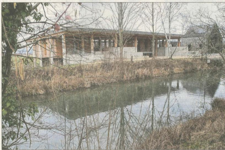
Au bord du vieux canal, la nouvelle Maison de la nature de Hirtzfelden, conçue pour accueillir le grand public ainsi que deux classes simultanément. À droite, l'ancienne maison éclusière, barquée de mélèze, occupée par les Brigades vertes. Photo l'Alsace
